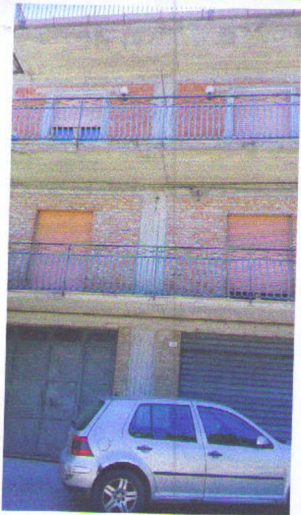
Foto1 Prospetto lato Nord Via Sant'Agostino 30- 32
